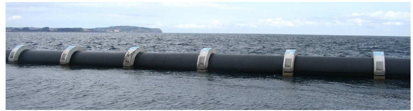
Emisario submarino de VICEDO (Luça)-lastres de fondeo
