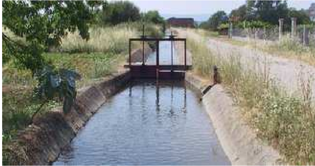
Canal de regadío en Monforte de Lemos (Lugo)
