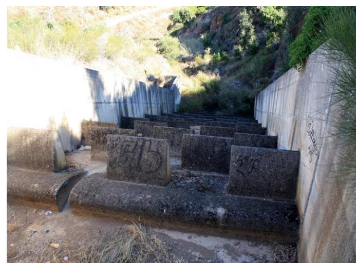
Disipador tipo IX del USBR
