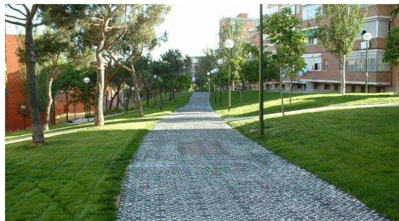
Pavimento de infiltración. Depósitos modulares
